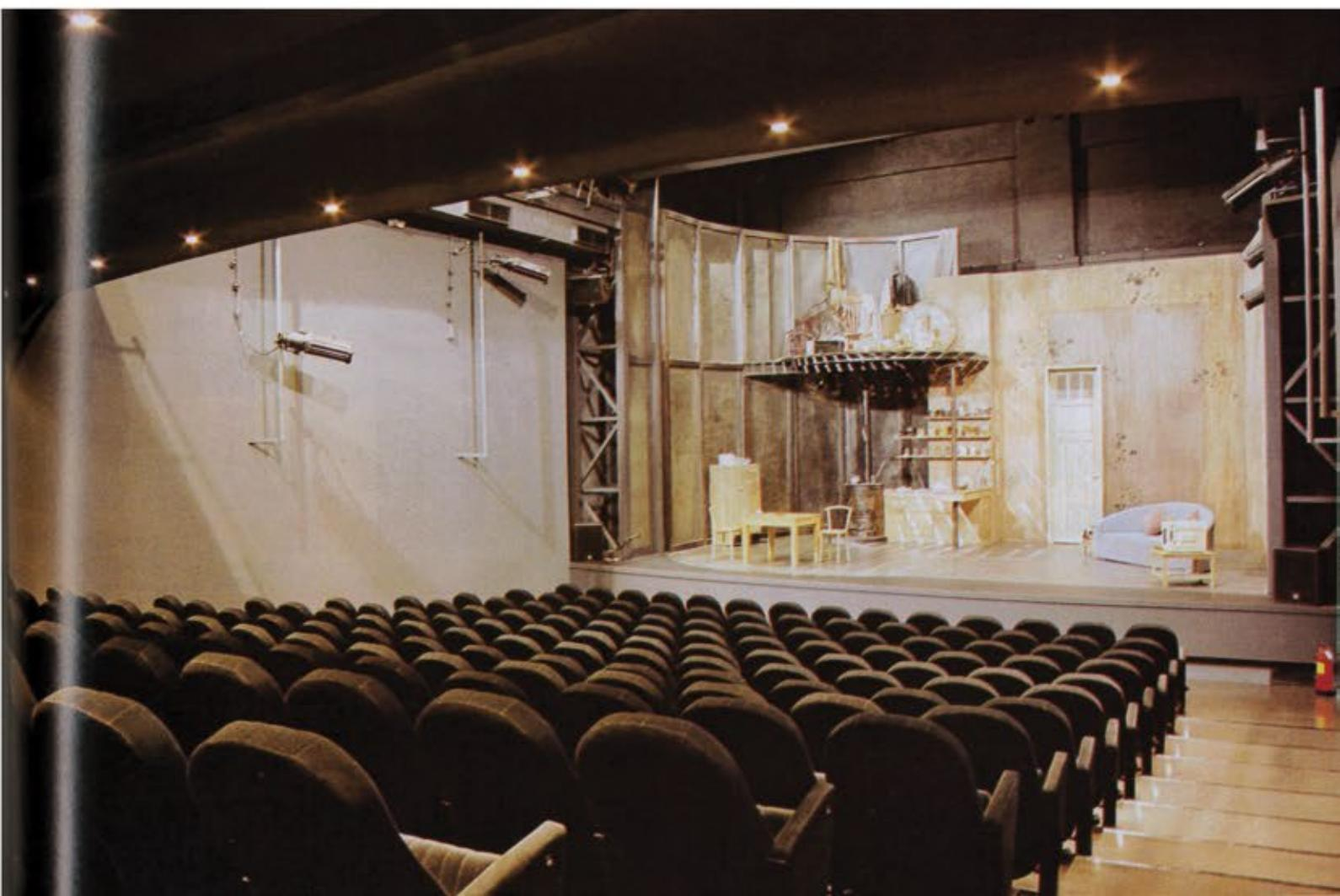
αναπτύσσονται οι αιγαγοί του κλιματισμού. Η σκηνή κατασκευάστηκε από μεταλλικά στοιχεία και ουδιαστικά από δύο πυλώνες που κρατάνε μια γέφυρα, ώστε να σχηματιστεί η μπούκα. Το πάνω μέρος της μπούκας ορίζεται από ένα μέτωπο ξύλινο που ταυτόχρονα κρύβει τη γέφυρα φωτισμού, κάποια φωτιστικά, τους οδηγούς της αυλαίας και λειτουργεί ως ανακλαστήρας.
