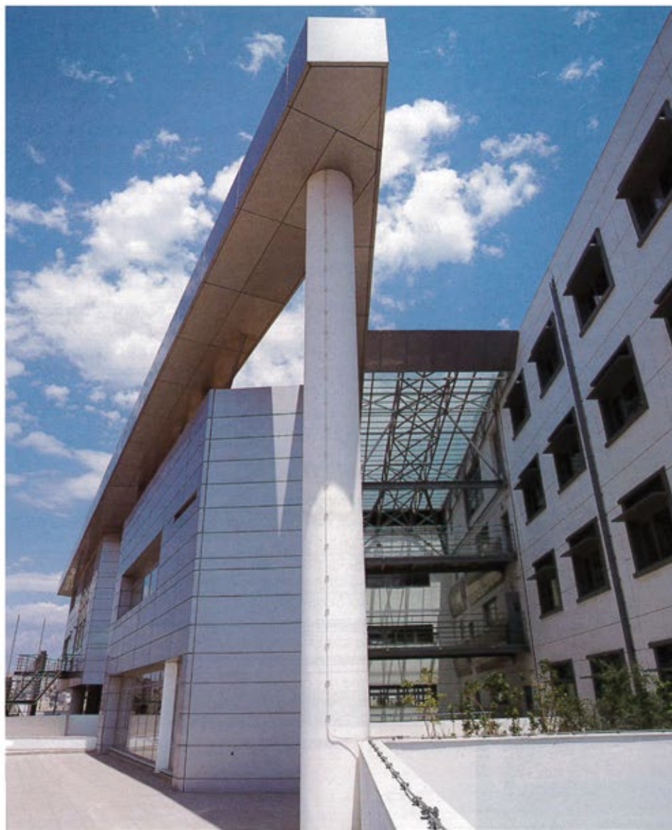
Η μεταλλική κατασκευή από φύλλα αλουμινίου στους άνω ορόφους.
