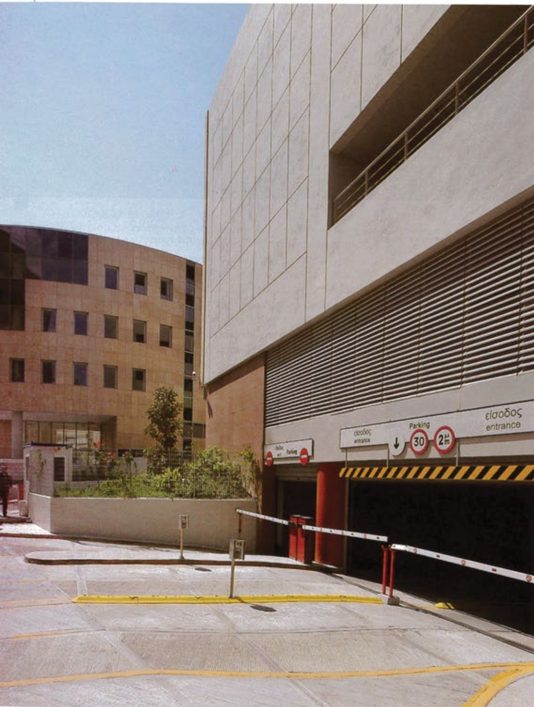
Το κτίριο της Γενικής Γραμματείας περιλαμβάνει 3 ορόφους υπόγειων πάρκινγκ. Στο βάθος το τετραώροφο κτίριο γραφείων και καταστημάτων, ιδιοκτησίας Σαριδη,
