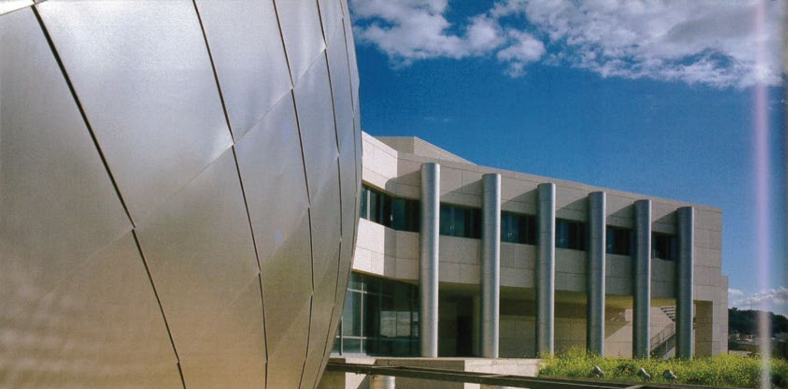
Εξωτερική άποψη του μουσείου, στην οποία διακρίνονται ο ελλειψοειδής όγκος και τα επιβλητικά κατακόρυφα μεταλλικά στοιχεία.
