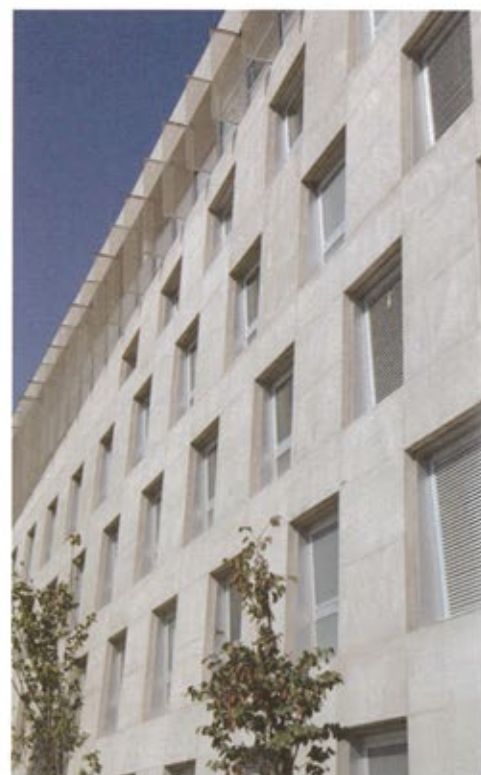
Λεπτομέρεια όψης από εμφανές σκυρόδεμα.
