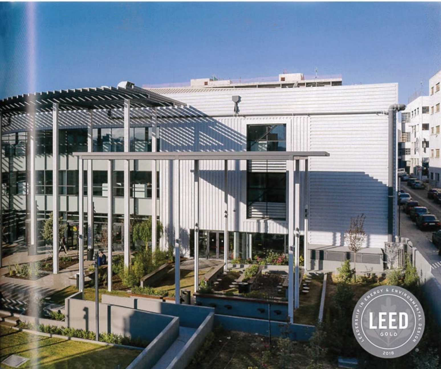
Η ΜΕΓΑΛΗ ΜΕΤΑΛΛΙΚΗ ΠΕΡΓΟΛΑ ΣΧΙΑΖΕΙ ΤΗ ΓΥΑΛΙΝΗ ΟΨΗ, ΣΥΝΘΕΤΟΝΤΑΣ ΠΑΡΑΛΛΗΛΑ ΕΝΑΝ ΕΞΩΤΕΡΙΚΟ, ΣΧΙΑΣΜΕΝΟ ΧΩΡΟ ΑΝΑΨΥΧΗΣ ΓΙΑ ΤΟΥΣ ΕΡΓΑΖΟΜΕΝΟΥΣ.
