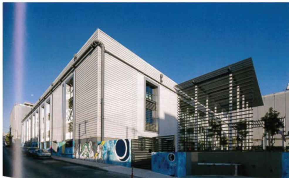
ΤΟ ΚΕΛΥΦΟΣ ΑΠΟΤΕΛΕΙΤΑΙ ΑΠΟ ΠΕΤΑΣΜΑΤΑ ΠΟΛΥΟΥΡΕΘΑΝΗΣ, ΜΕ ΕΞΩΤΕΡΙΚΗ ΟΨΗ ΛΑΜΑΡΙΝΑΣ.
