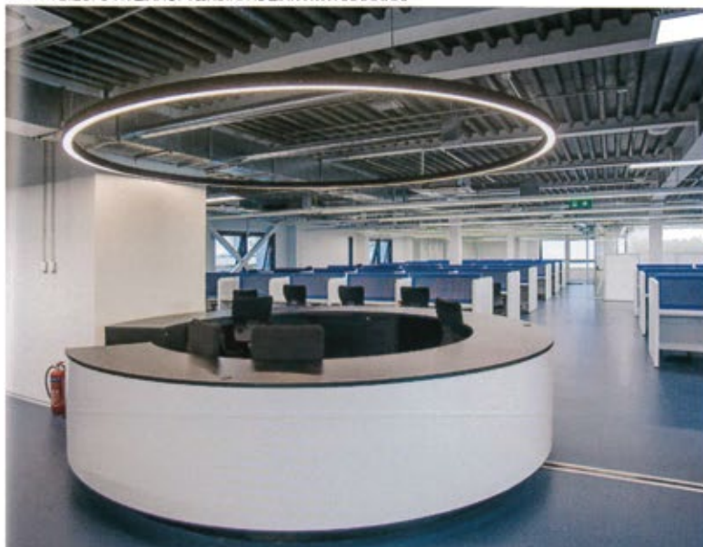
ΣΤΟ ΕΣΩΤΕΡΙΚΟ ΕΝΟΣ ΧΩΡΟΥ ΓΡΑΦΕΙΟΥ, ΟΙ ΑΕΡΑΓΟΙ ΚΑΙ Ο ΤΕΧΝΗΤΟΣ ΦΩΤΙΣΜΟΣ ΕΙΝΑΙ ΟΡΑΤΟΙ, ΕΝΩ Η ΨΕΥΔΟΡΟΦΗ ΔΙΑΜΟΡΦΩΝΕΤΑΙ ΜΕ ΔΙΑΤΡΗΤΗ ΛΑΜΑΡΙΝΑ.
