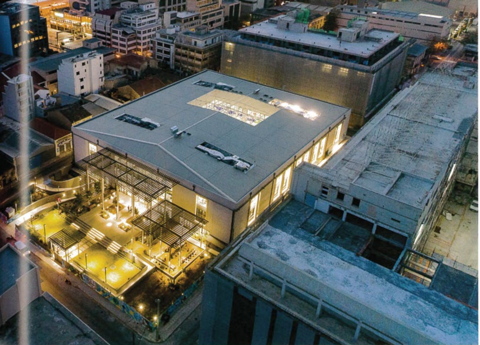
ΤΟ ΚΕΛΥΦΟΣ ΤΗΣ ΠΑΛΙΑΣ ΑΠΟΘΗΚΗΣ ΔΙΑΜΟΡΦΩΘΗΚΕ ΜΕ ΠΕΡΙΜΕΤΡΙΚΑ ΑΝΟΙΓΜΑΤΑ, ΑΛΛΑ ΚΑΙ ΕΝΑ ΝΕΟ ΚΕΝΤΡΙΚΟ ΑΙΘΡΙΟ.
