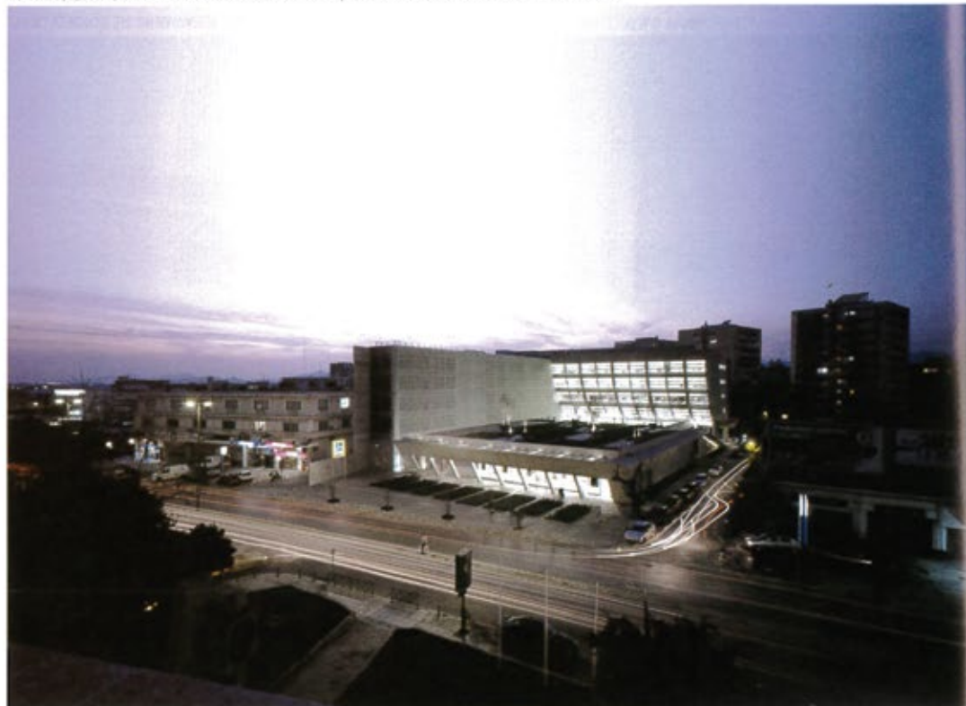
ΤΟ ΚΤΙΡΙΟ ΣΥΝΤΗΘΕΤΑΙ ΑΠΟ ΔΥΟ ΕΠΙ ΜΕΡΟΥΣ ΟΓΚΟΥΣ, ΕΝΑ ΜΟΝΩΡΟΦΟ ΚΑΙ ΕΝΑΝ ΠΕΝΤΑΩΡΟΦΟ.
