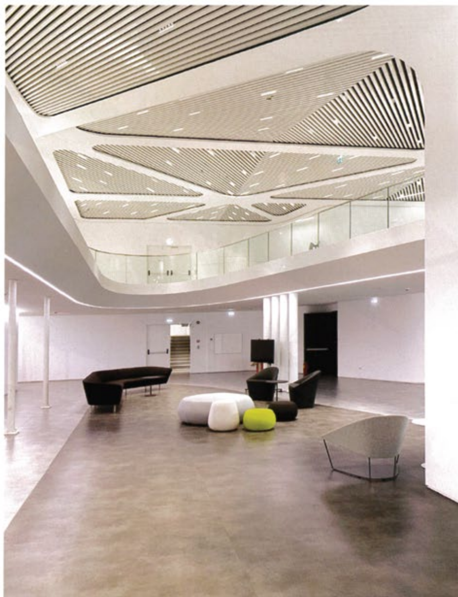
Η ΕΠΕΝΔΥΣΗ ΤΗΣ ΟΡΟΦΗΣ ΕΓΙΝΕ ΜΕ ΔΙΑΤΡΗΤΑ ΠΕΤΑΣΜΑΤΑ, ΟΣΤΕ ΝΑ ΛΕΙΤΟΥΡΓΕΙ ΩΣ ΑΚΟΥΣΤΙΚΗ ΟΡΟΦΗ, © LC ARCHITECTS.
